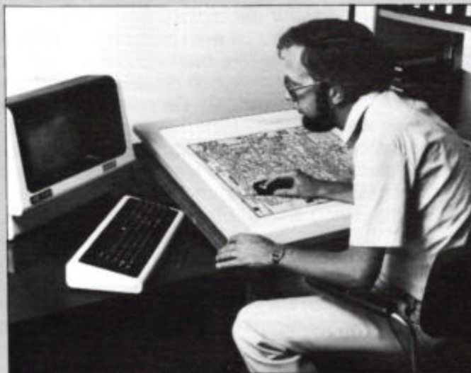
(2). Na het ontwerpen en tekenen van de masker-layout wordt deze met behulp van digitizer ingevoerd in een computer.
